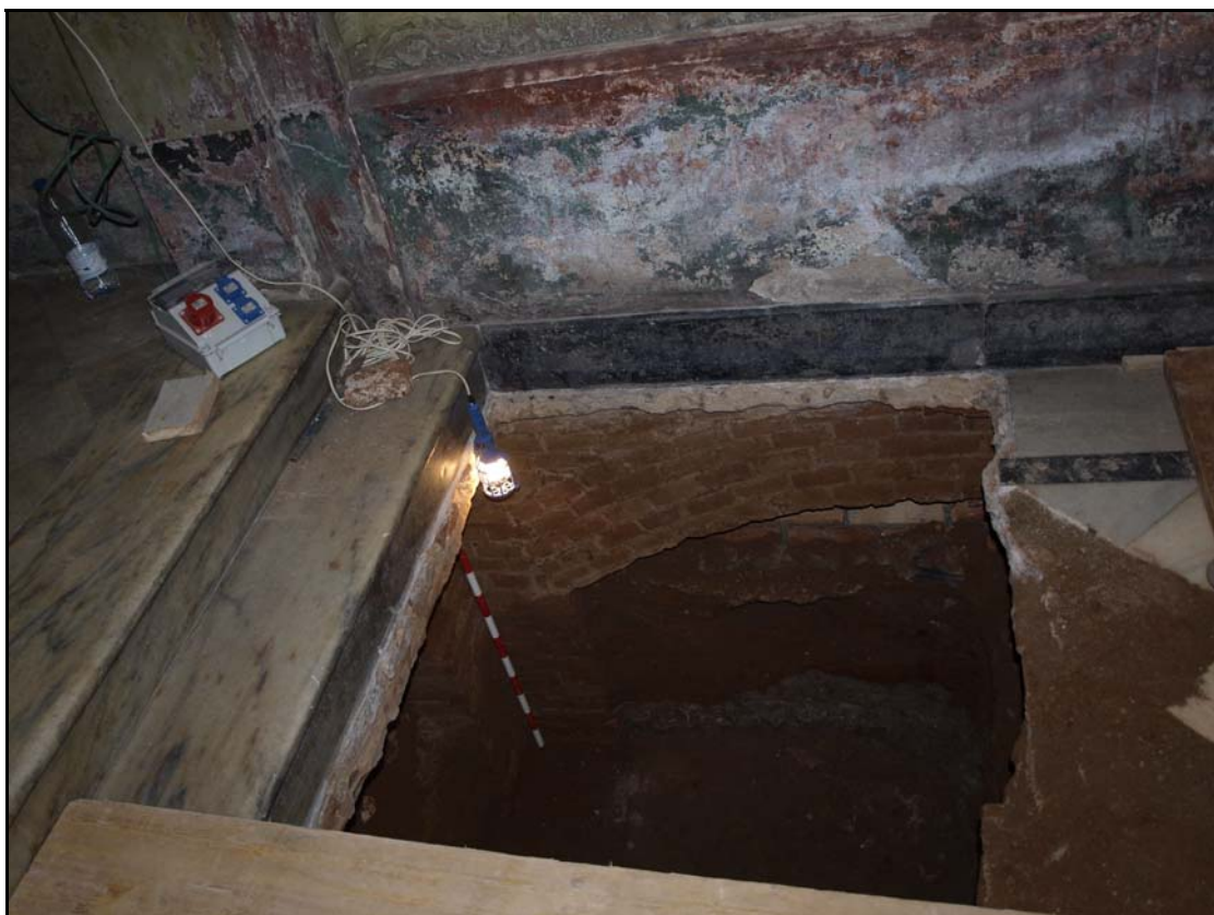
Fotografia 9. Vista general d'un arc de descarrega i part de la paret.
