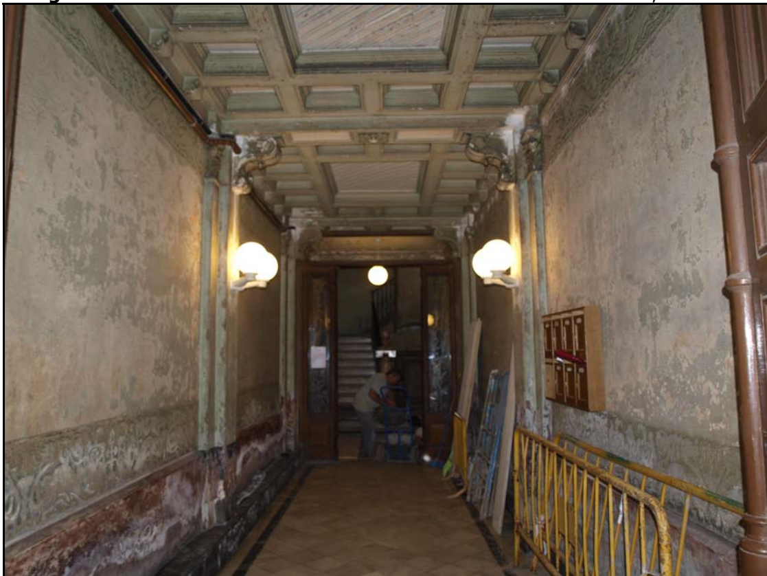
Fotografia 2. Entrada de la finca on es realitzava el fossat de l'ascensor. Es pot apreciar el nivell de paviment U.E.100.
