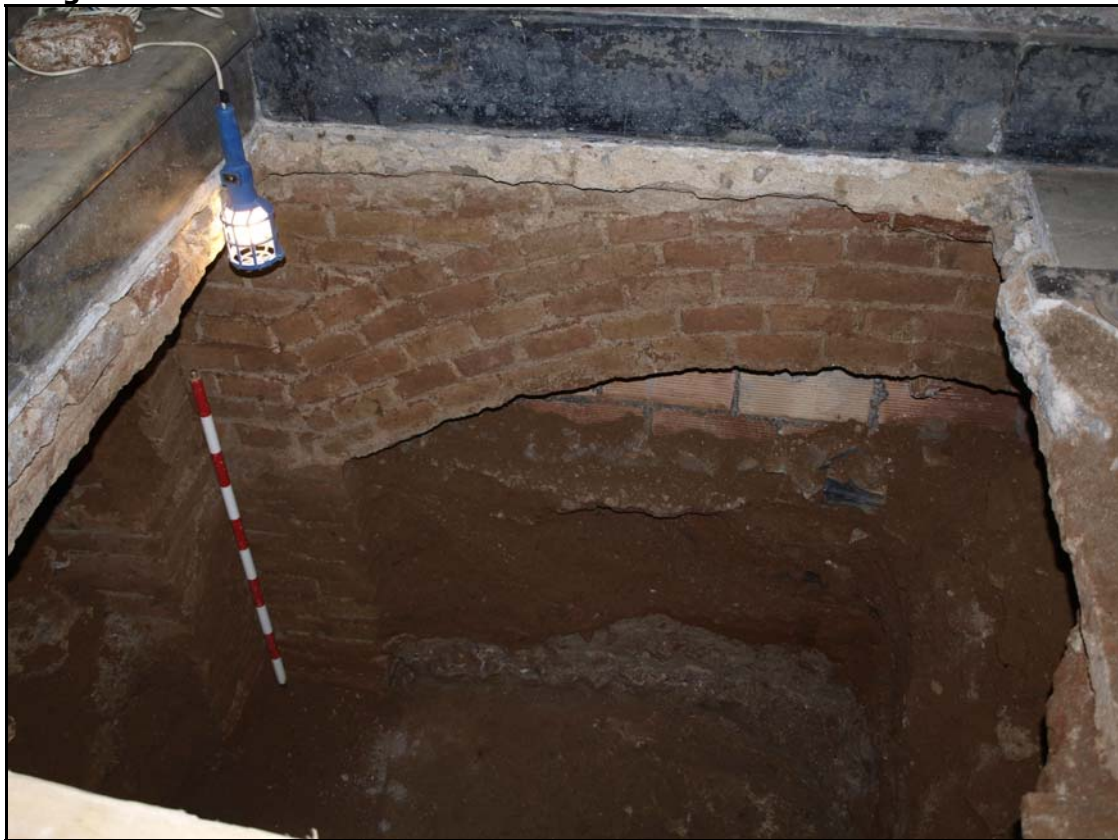
Fotografia 8. Vista general d'un arc de descarrega de la fonamentació del edifici.
