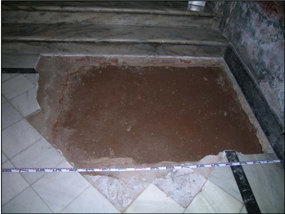
Fotografia 3. Detall des de l'est la situació del fossat de l'ascensor un cop aixecats els diferents nivells de paviment documentats.
